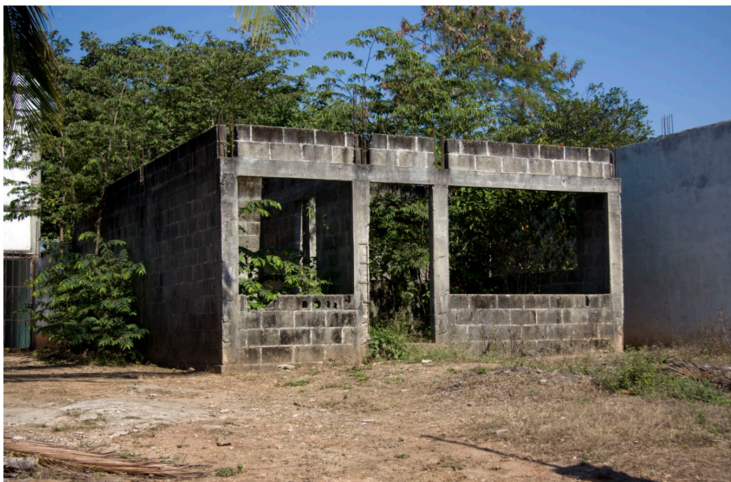
Una casa en construcción – temporalmente abandonada Tres Valles, Veracruz, México
